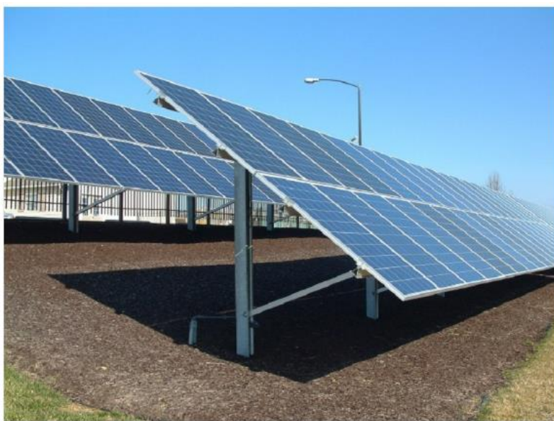
Figur 14, solpanelsinstallation med pålat fundament, samt typisk utrustning för pålning.
