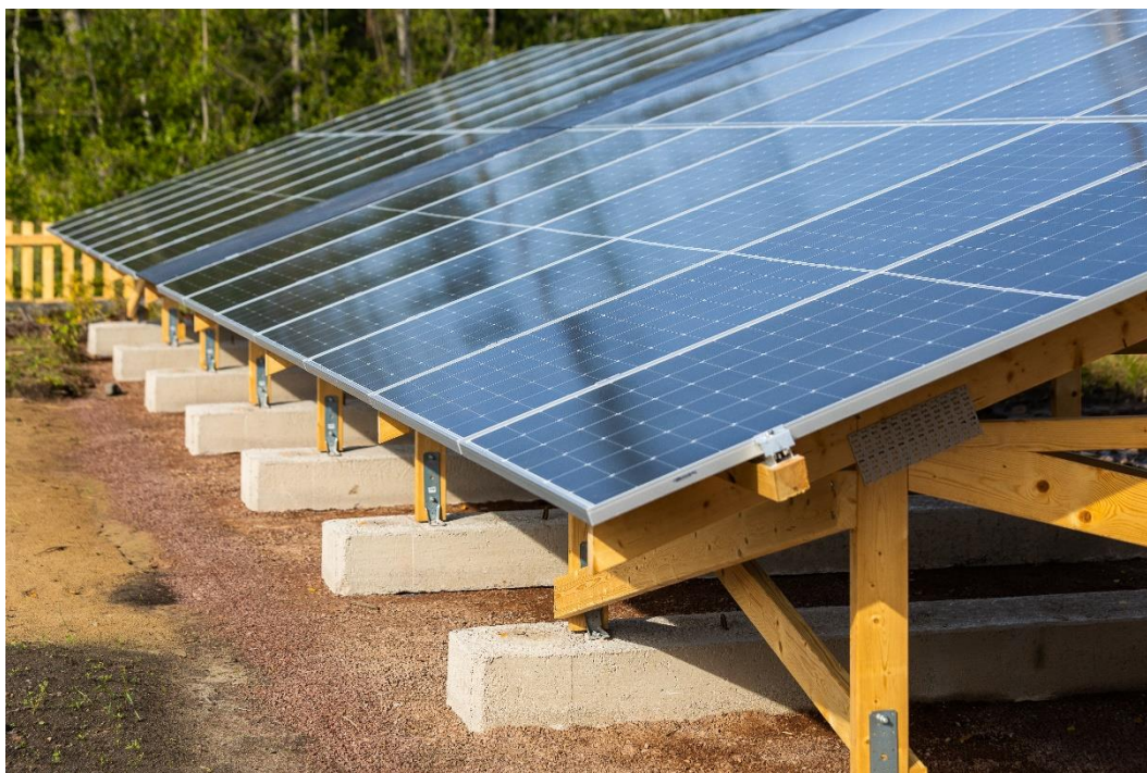
Figur 15, gravitationsfundament i betong, OX2 pilotanläggning i Möckelö.
